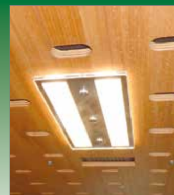
Die Innenbeleuchtung in der Decke eingelassen
