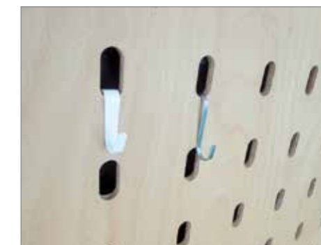
Handelsübliche Haken können in das Lochsystem eingehängt werden.
