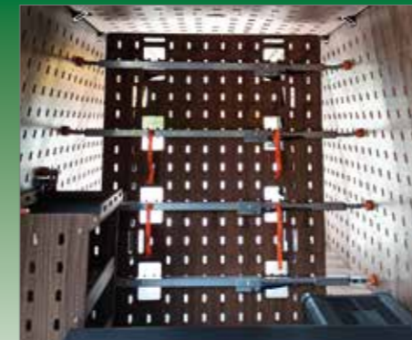
Befestigung der Trennwand mit den Sperrstangen
