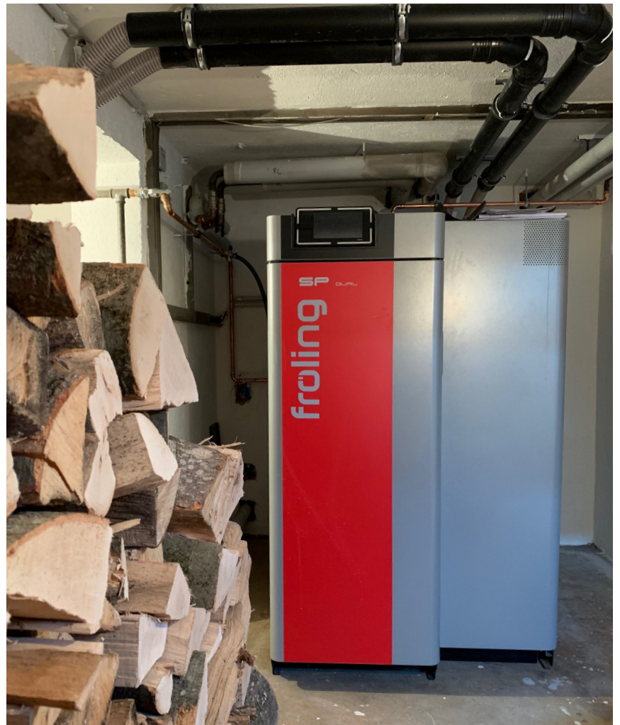
Der Scheitholz-Pellets-Kombikessel ist ein Element des Gesamtkonzepts der Energieversorgung. (Foto: Automobile Römerstein GmbH)
